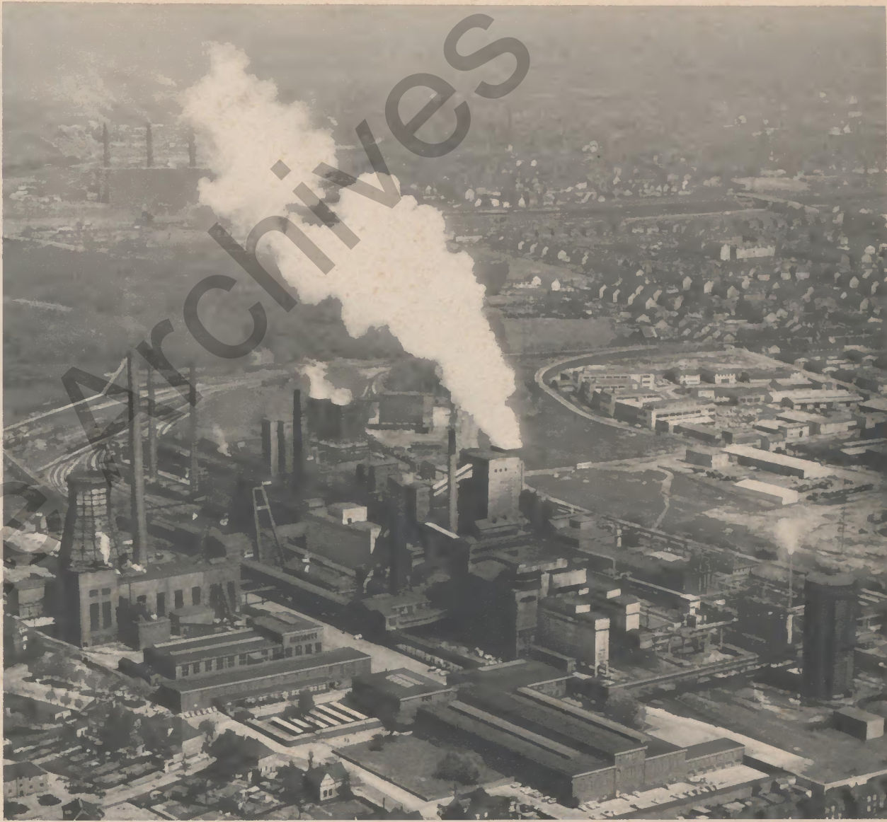
1 Das Luftbild der Schachtanlage Emil-Emscher, von Südwesten aus gesehen, gibt einen einmaligen Überblick über den Gesamtkomplex der Zeche rund um die beiden Fördergerüste der Schächte Emil 1 und Emil 2 und die Betriebsanlagen der Kokerei Emil. Im Vordergrund des Bildes das langgestreckte Kauengebäude, die Werkstätten und das Maschinenhaus
