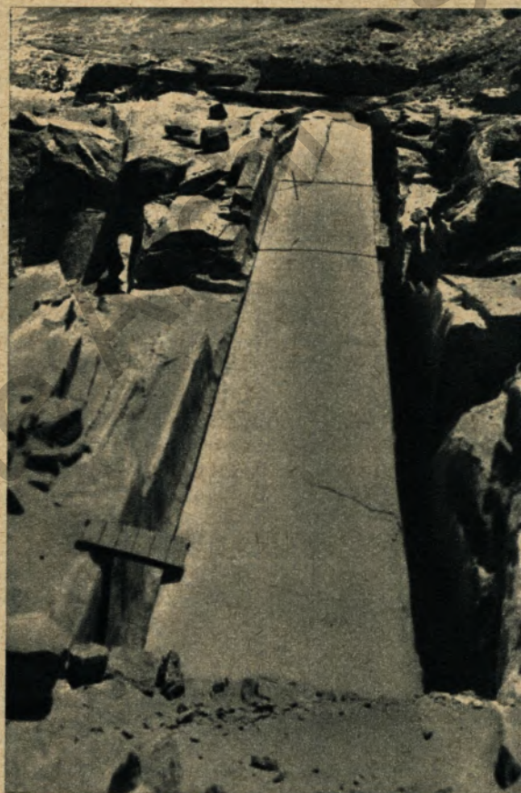
Der „unvollendete“ Obelisk, Steinsäule, aus einem Granitstück in Assuan von 36 m Länge, 1500 v. Chr. Die Seitenflächen sind aus dem homogenen Granit bereits herausgearbeitet. Unten besteht noch der Zusammenhang mit dem gewachsenen Stein.
