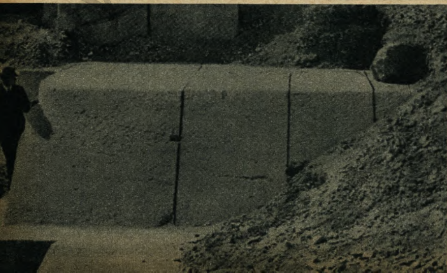
Decksteine der Cheops-Pyramide aus Kalkstein. Die Fugen von 0,5 mm (!) Breite sind mit Holzkohle nachgezeichnet, um sie sichtbar zu machen.
