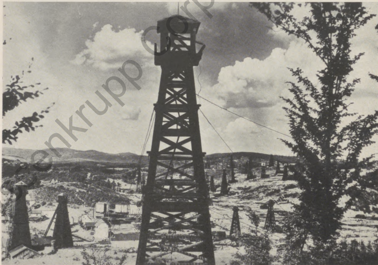
Ölfeld Moreni mit Bohrtürmen, Rumänien, Scherl Bilderdienst
