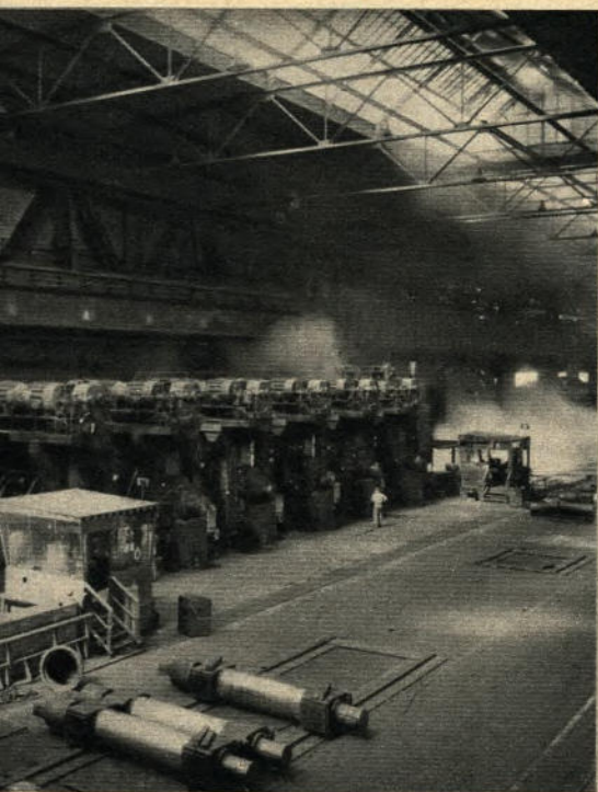
◀ So sah das verwüstete Blechwalzwerk 3 der Westfalenhütte nach dem Kriegsende aus; daneben ein Blick in die 1958 errichtete Breitbandstraße
