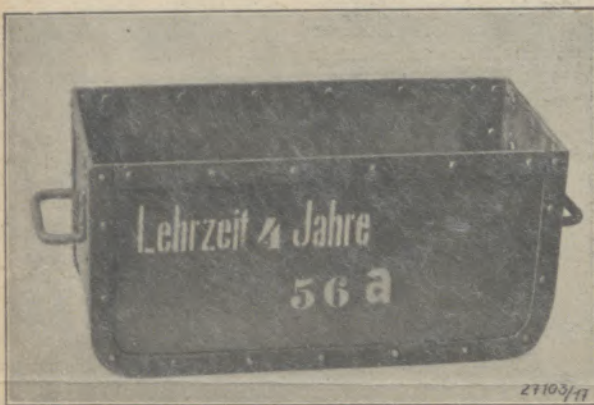
Bild 4: Facharbeit für Bauschlosser: Spänekasten. Ausführung
