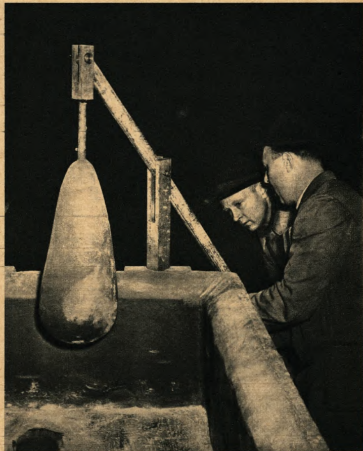
Ganz unten im Bildrand das Loch im Gießkasten, durch das das flüssige Eisen hinausläuft. Darüber der Verschuß - eine Lehmbirne - an langem Hebel, dessen Bedienung Karl-Heinz Mahlberg (ganz rechts) gerade erklärt
