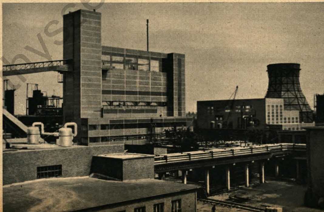
Die Druckvergasungsanlage in Hervest-Dorsten vergast ballastreiche Kohle
