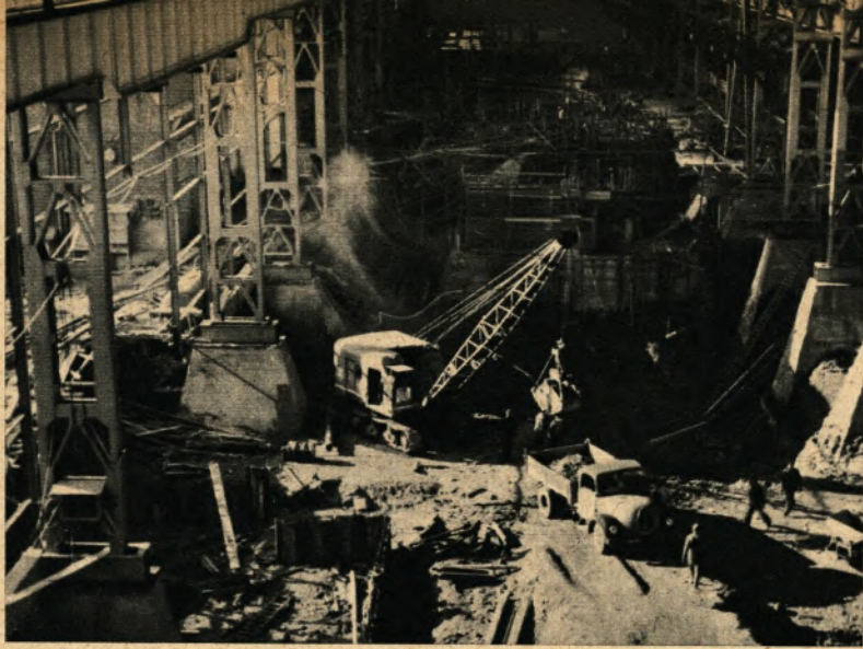
Abb. 3 Bei den Fundamentierungsarbeiten mußten 60000 Kubikmeter Erde bewegt und 43000 Kubikmeter Beton hergestellt werden
