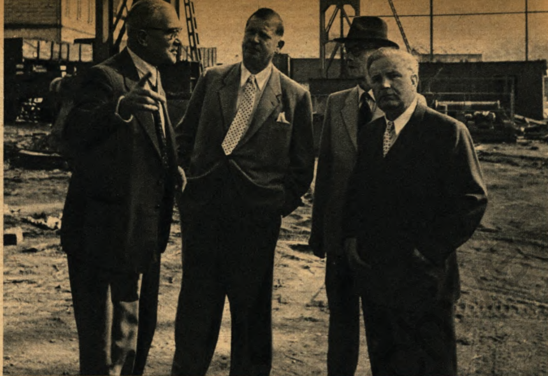
Abb. 8 Friedrich Wilhelm Engel, der im vergangenen Jahr verstarb (Mitte), mit Dr. Ing. E. h. Willy Ochel (ganz rechts) und Hüttendirektor a. D. Alfred Brüninghaus (halbrechts) bei einer Besichtigung der Baustelle im Gespräch mit Dr. Ing. Toni Wimmer
