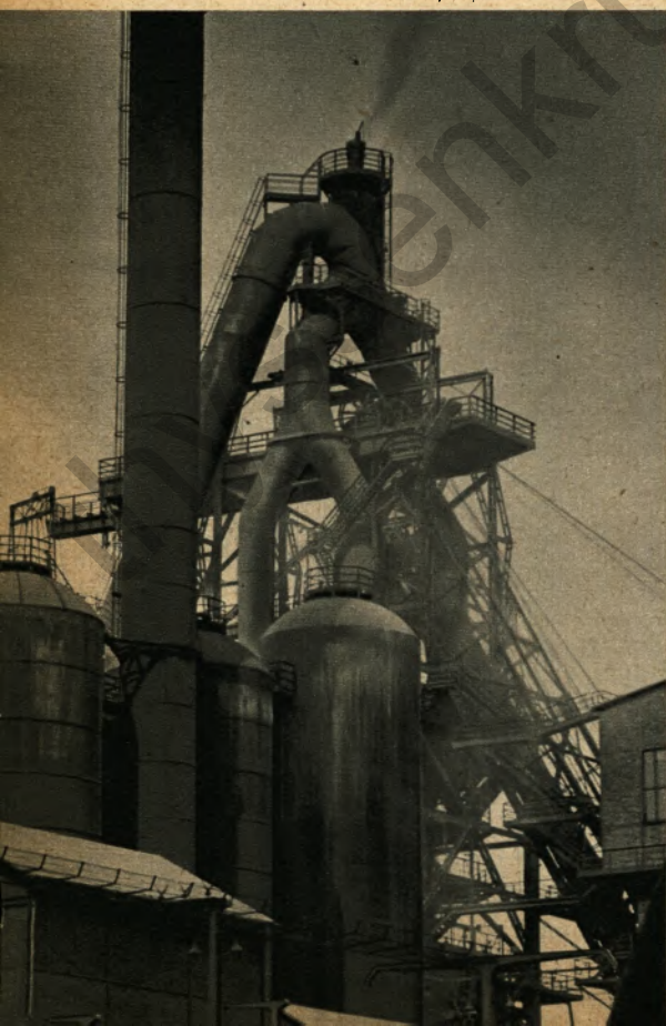
Einen Teil des erzeugten Gichtgases verbraucht der Hochföfen selbst für die Winderhitzer (Vordergrund links)
