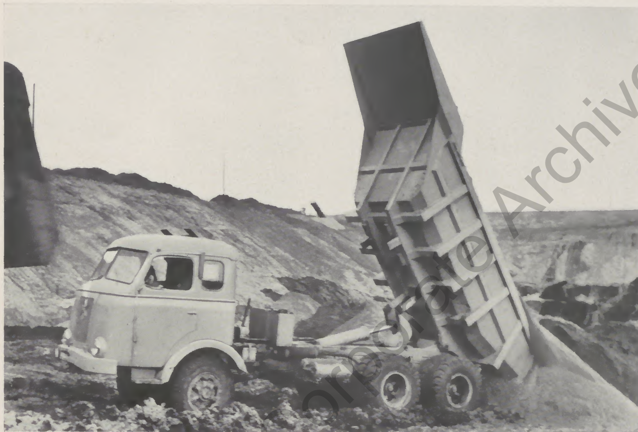
Henschel Muldenkipper HS 3-180 mit Allradantrieb in schwerstem Gelände; Zuladung 20 t, 10m 3 Fassungsvermögen
