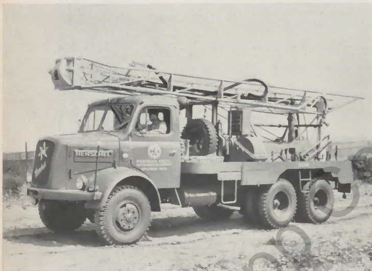
Fahrbare Failing-Bohr-Anlage, Modell CED-1 B Holmaster, auf Henschel HS 3-125, Allrad-Antrieb, 6x6, Radstand 3900 mm, im Dienst der Deutschen Erdöl-Aktiengesellschaft (DEA), Wietze
