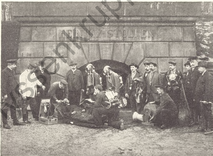
Rettungstruppe des Heinrich-Stollens Ausgerüstet mit Sauerstoff-Rettungsapparaten und Sauerstoffkoffer zur Wiederbelebung (System Dräger)
