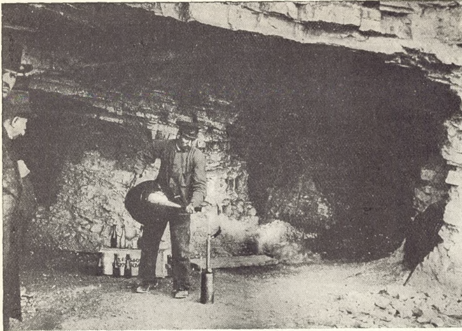
Flüssige Luft als Sprengstoff Abfüllen von flüssiger Luft in die Sprenggefäße im Bergwerk
