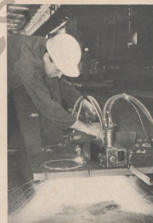
▲ Von der Zuverlässigkeit des Materials hängt das Wohl und Wehe der Passagiere, der Besatzung und der Ladung ab – kein Wunder, daß die Schiffsbleche besonders streng kontrolliert werden. So wird bei dicken Blechen von jedem einzelnen zur Probe ein Stück entnommen – auf unserem Foto brennt Egon Richter ein Stück ab
