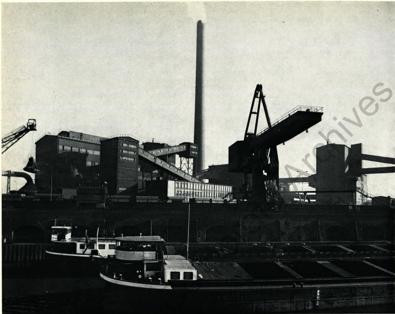
Erztladekai im Südhafen Walsum. Dahinter das Erzbrechwerk.
