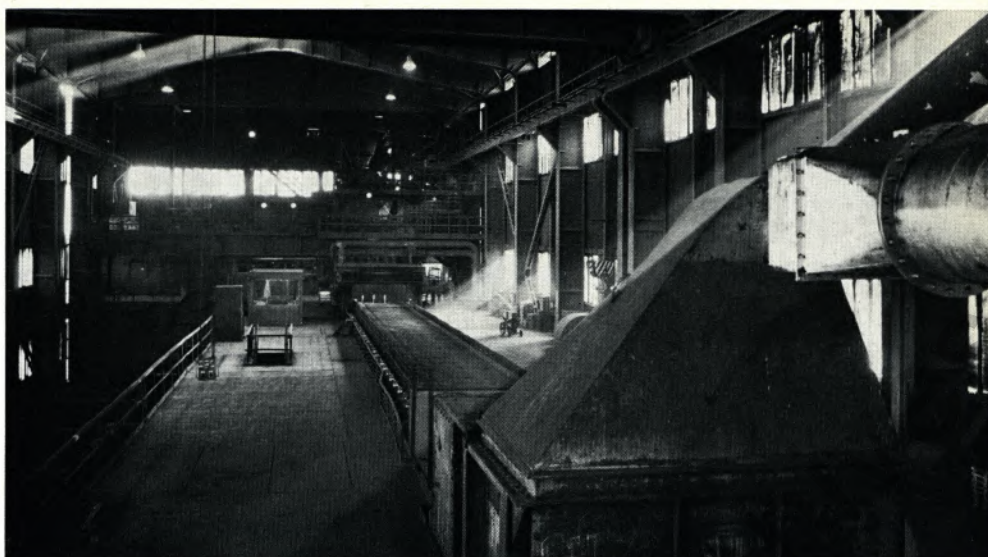
Bild oben: Die Sinteranlage. In der Mitte das Sinterband. Bild unten: Der Drehkühler, in dem der Sinter gekühlt wird.
