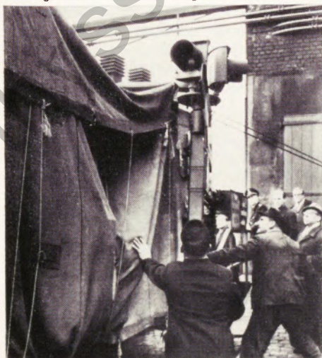
Ein Signalmast steht im Wege
