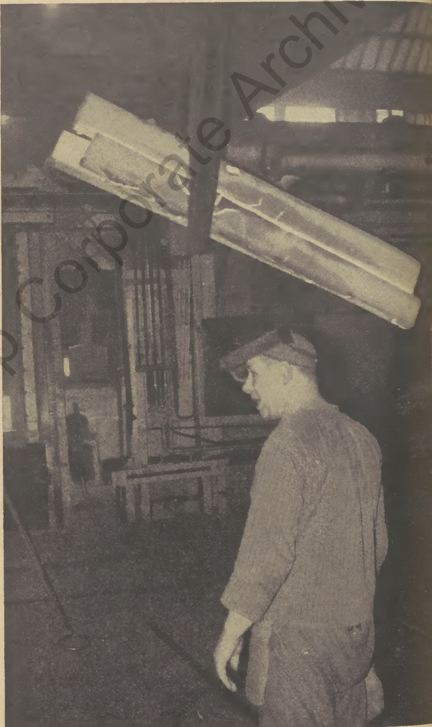
Vorsicht! Der Tiefofenkran fährt mit drei vorgewalzten Knüppeln am Stoßofen vorbei zur Blockstraße. Fotos: Heinz Müller
