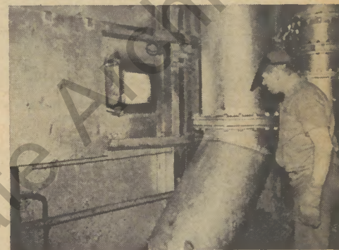
Bilden sich im Ofen auch keine Zunderbuckel? Ein Blick durch eine der kleinen Seitenöffnungen gibt Antwort.
