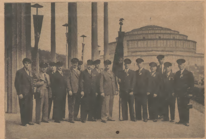
Vor der Jahrhunderthalle in Breslau
