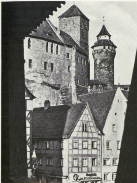
Nürnberg, Kaiserburg mit Sinwellturm
