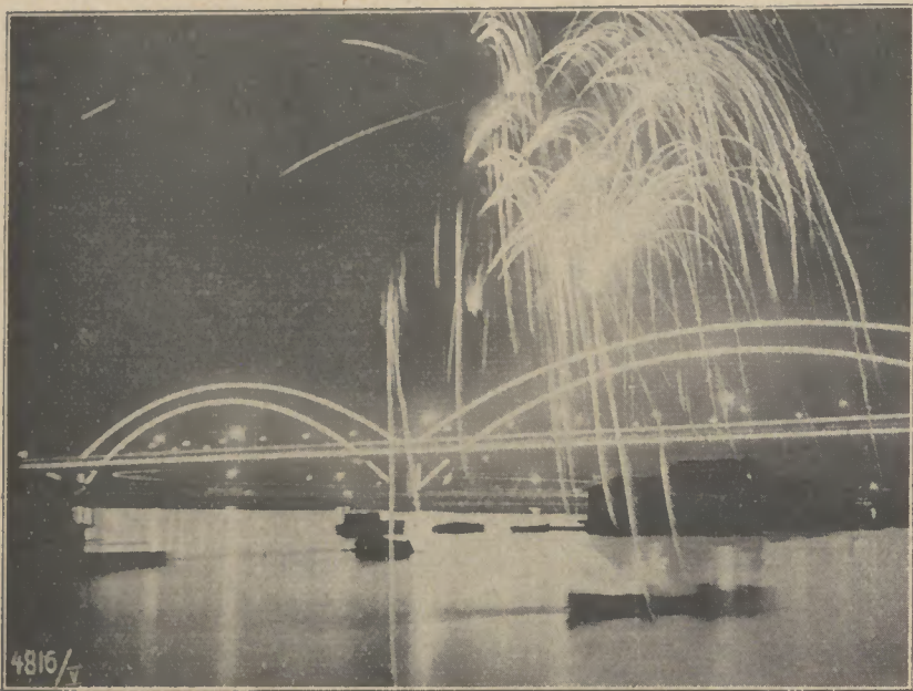
Beleuchtung der Düsseldorfer Rheinbrücke
