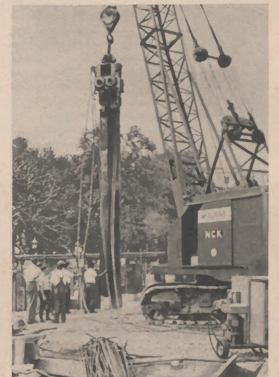
▼ Nur eine Spundwand kann leicht und ohne Abbruchmaterial entfernt werden. Unser Bild zeigt, wie die Bohlen mit dem jetzt von der Schmiedag hergestellten Müller-Vibrationsramm- und -Ziehgerät gezogen werden. Danach können sie auf der nächsten Baustelle wieder eingesetzt werden
