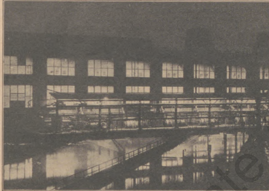
Gaszentrale bei Nacht (Werk Dortmund) Aufnahme von Lütke, Walzendreherei Werk Dortmund
