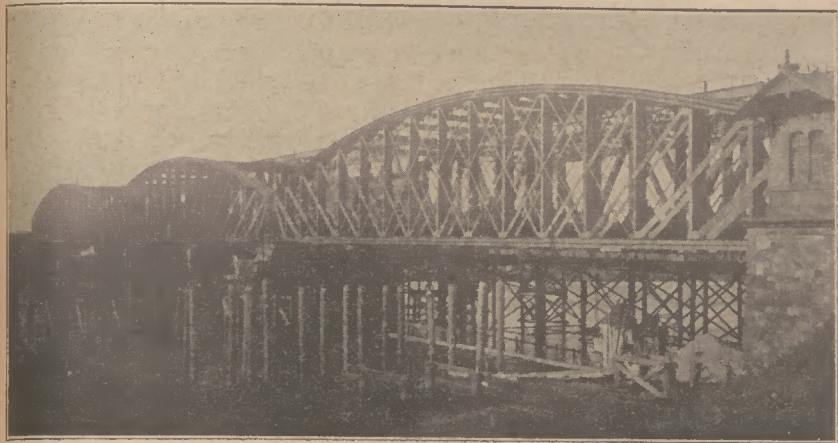
Ansicht der alten Brücke.
