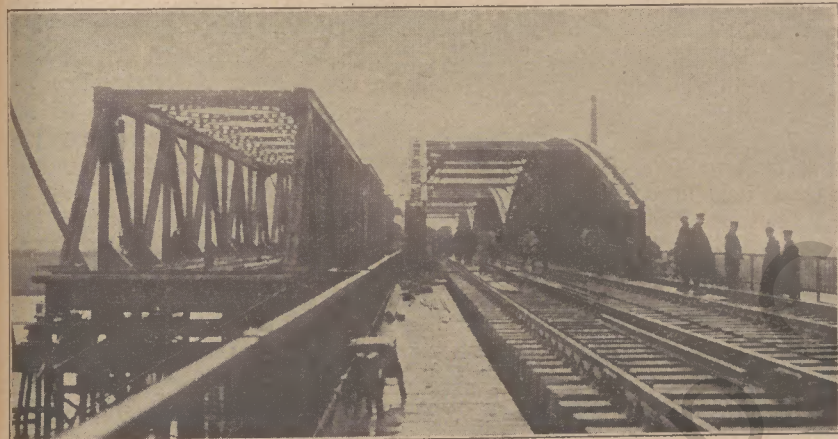
Alte und neue Brücke vor dem Auschieben.
