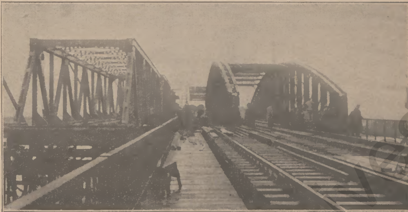
Beginn des Auschiebens der alten Brücke.
