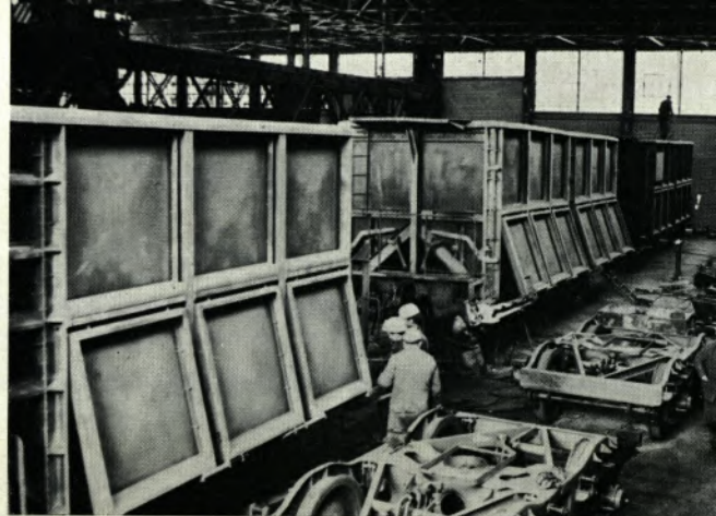
So eng und dunkel sah es früher in der Wagenreparatur aus. Hallenkonstruktion und Platzmangel erlaubten kaum den Einsatz moderner techn.
