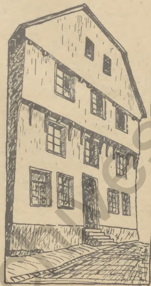
Fassade eines Alt-Hattinger Bürgerhauses, ganz in Bruch- u. Feldbrandsteinen ausgeführt.
