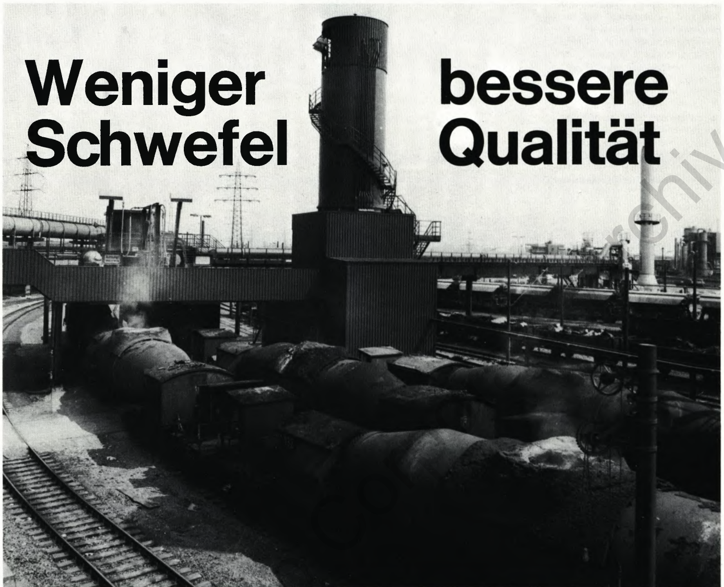
Die Entschwefelungsanlagen in Ruhrort und Beeckerwerth sind im Aufbau ähnlich: Jeweils eine Brücke über Eisenbahngleise, auf denen die Rohisenbehälter unter die Lanzen gefahren werden, mit denen Preßluft in das Roheisen eingeblasen wird. Hier die Anlage Beeckerwerth.
