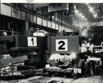
Die neue Stranggießanlage des Werkes ATH
