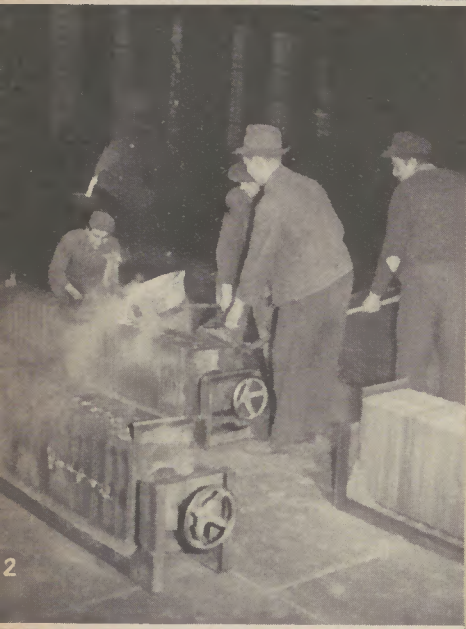
Abb. 11: Arbeitsgruppe bei der Herstellung von Formmasken nach Croning mit Former Krockhaus.
