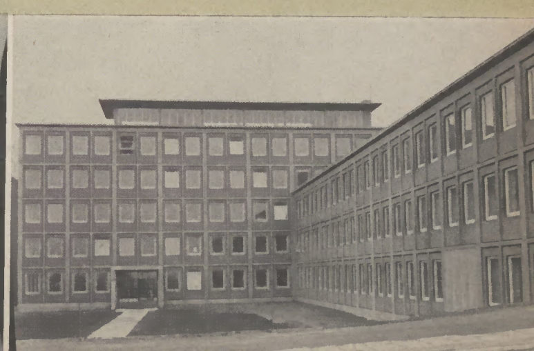
Abb. 16: Das neuerstellte Betriebsgebäude mit Versuchsanstalt.
