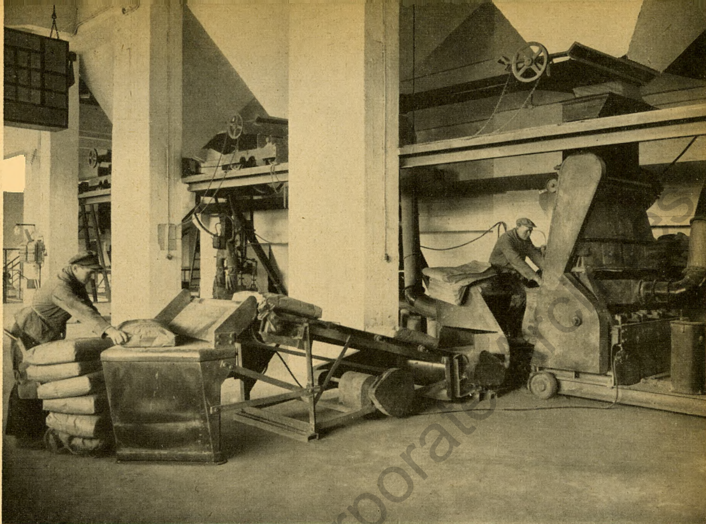
An einer Abfüllmaschine in unserer Zementfabrik
