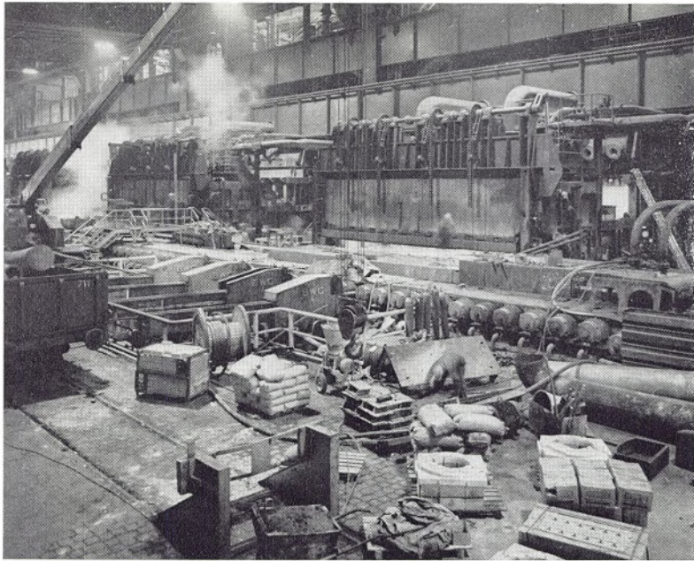
DAS BILD zeigt Reparaturarbeiten an den Stoßöfen der Warmbreitbandstraße in Beeckerwerth
