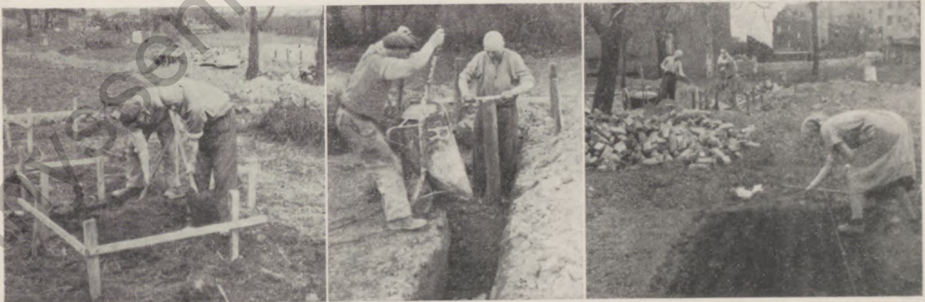
Schnappschüsse vom Behelfsheimbau. Links: Der erste Spatenstich zu dem neuen Heim. Mitte: Schon wachsen die Fundamente aus der Erde. Rechts: Während die Männer am Bau beschäftigt sind, bestellt die Frau schon den zum Haus gehörenden Garten.
