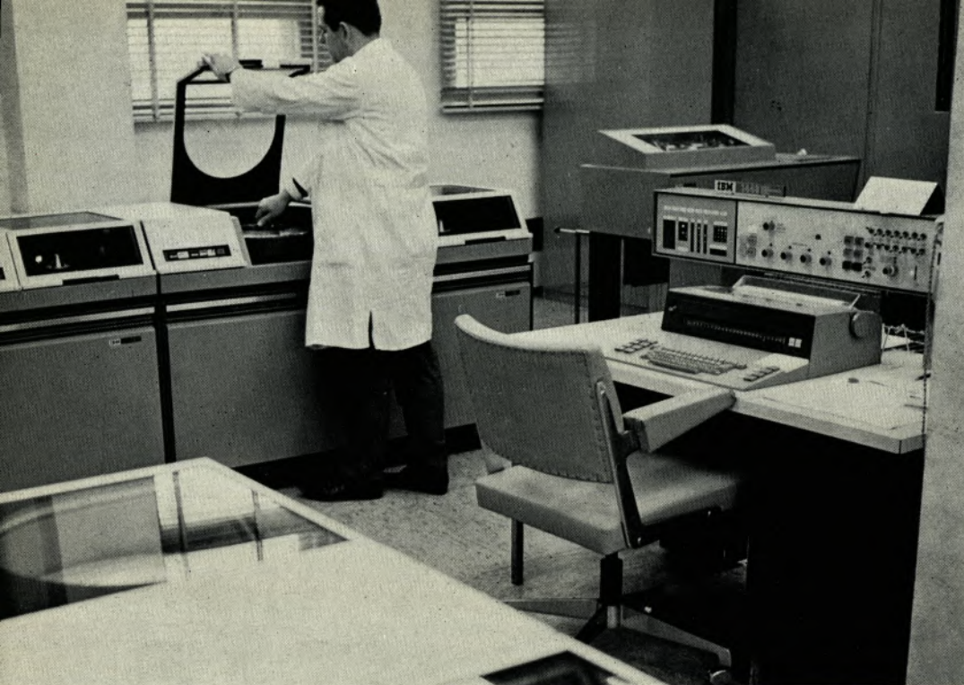
Blick in die Zentrale mit der IBM-1440-Anlage, den Platten-speichern und dem Drucker.
