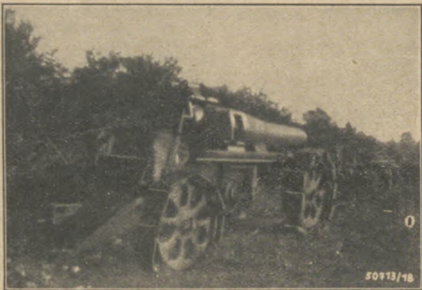
Bild 2: Rohrwagen mit Radgürtel
