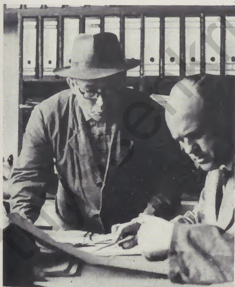
▲ Kaltbetriebsmeister: Disponieren nach Terminplan
