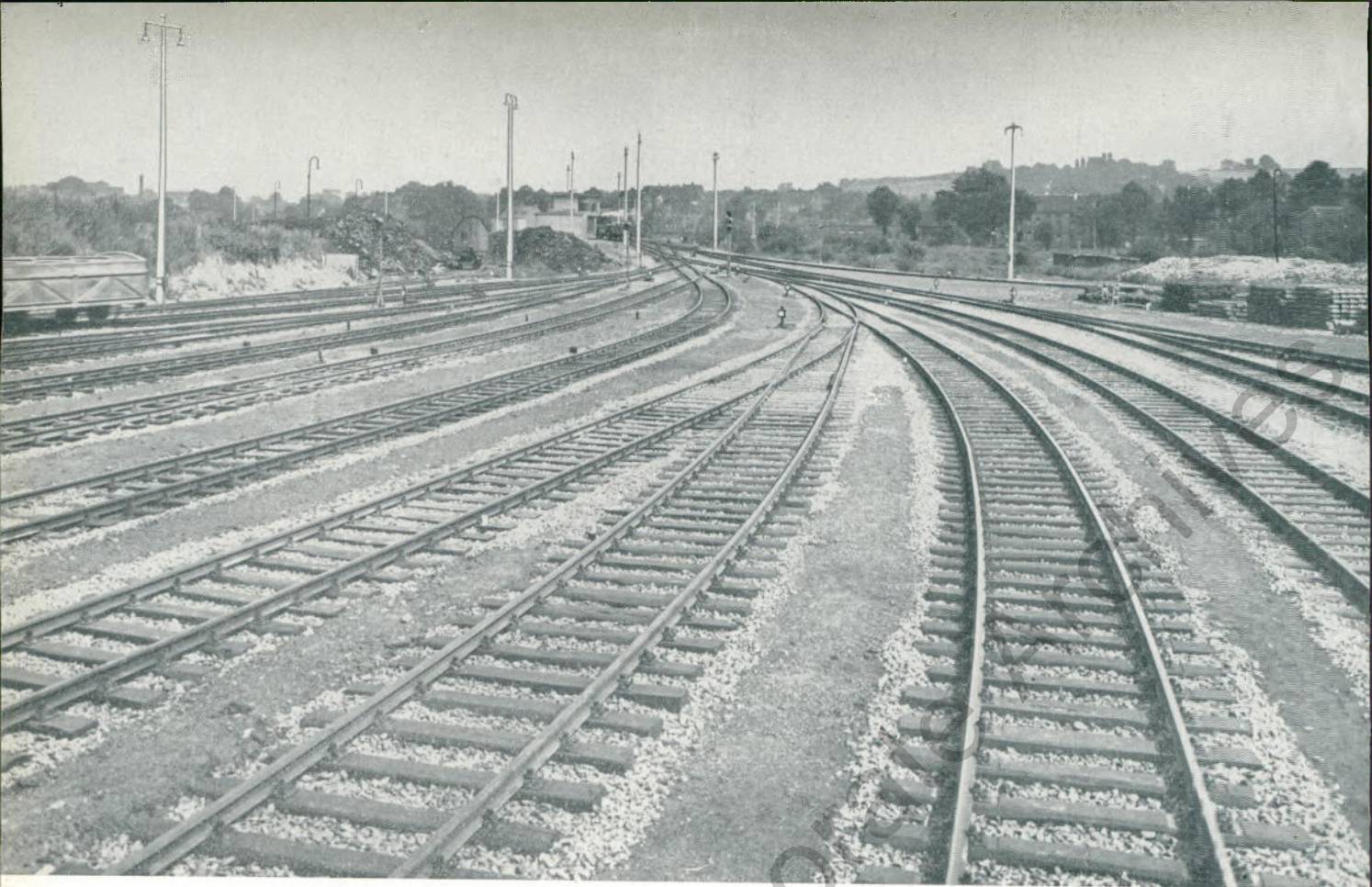
Abb. 2 Ostl. Teil der Gleisanlage des neuen Bahnhofs
