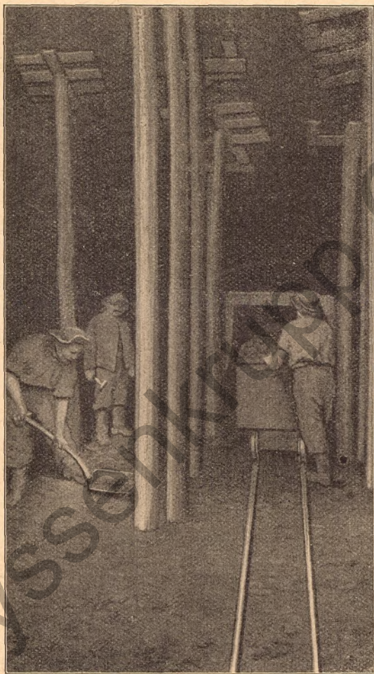
Abb. 17. Tiefbau — Pfeilerbruchbau im Braunkohlenflöz
