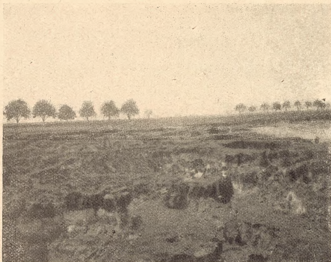
Abb. 18. Bruchfeld über einem abgebauten Braunkohlenflöz bei Gerlebogt in Anhalt
