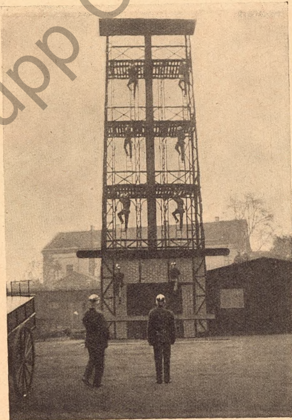
Abb. 3. Steiger am Turm
