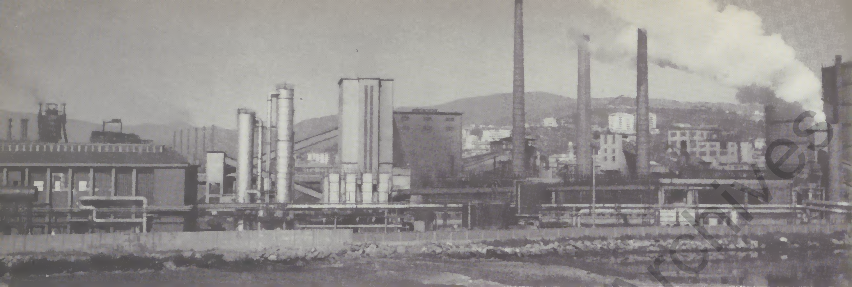
Blick auf die Anlage Cornigliano
