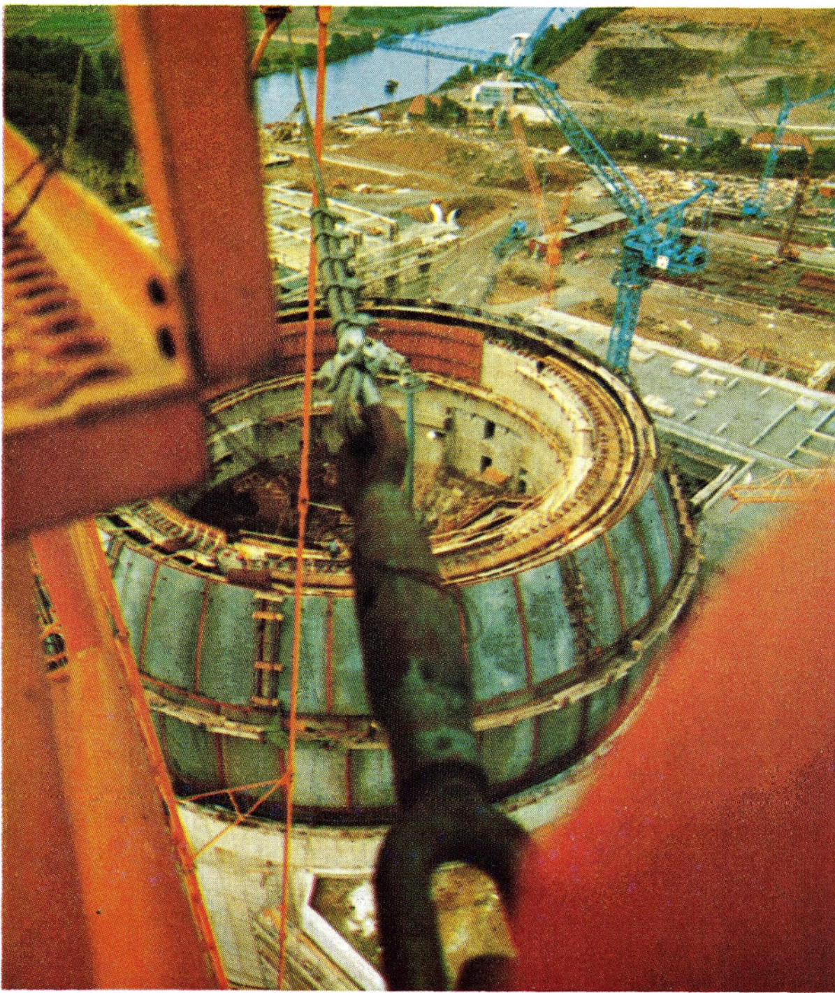
Ein Blick von oben auf die im Bau befindliche Sicherheitshülle. Deutlich sind die einzelnen Segmente erkennbar
