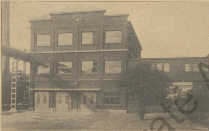
Der Feuerwehrturm nach dem Umbau im August 1936
