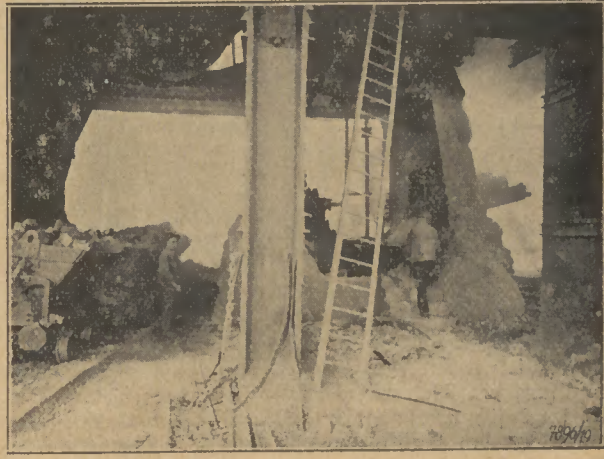
Der vor Unfall schützende Treppenübergang für die Passage des Schlackenbärs
