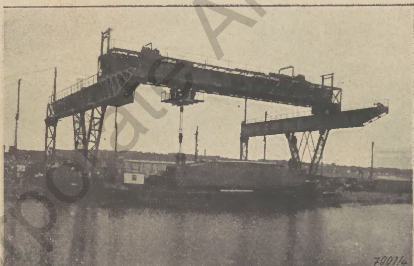
Verladen des Ballastkastens für die Königinbrücke in Rotterdam in den Kahn
