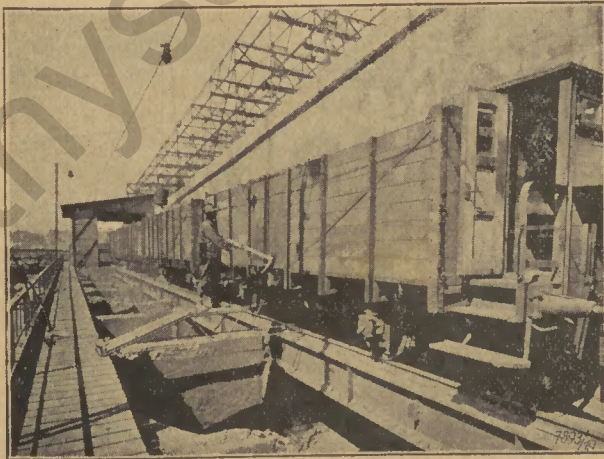
Der Sicherheitschlitten zum Öffnen bei beladenen Waggonen über Bunker
