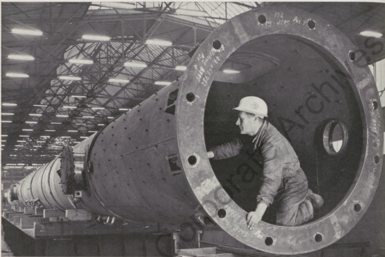
Eine Fraktionierkolonne die für die Chemische Industrie in den Niederlanden angefertigt wurde.
