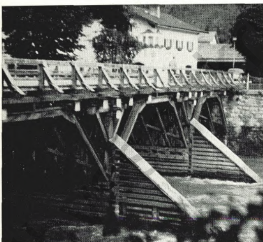
Nach heftigen Regenfällen steigt die Salzach in Schwarzach stark an. Aber auch bei normalem Wasserstand schäumt sie mächtig gegen die Brückenpfeiler
