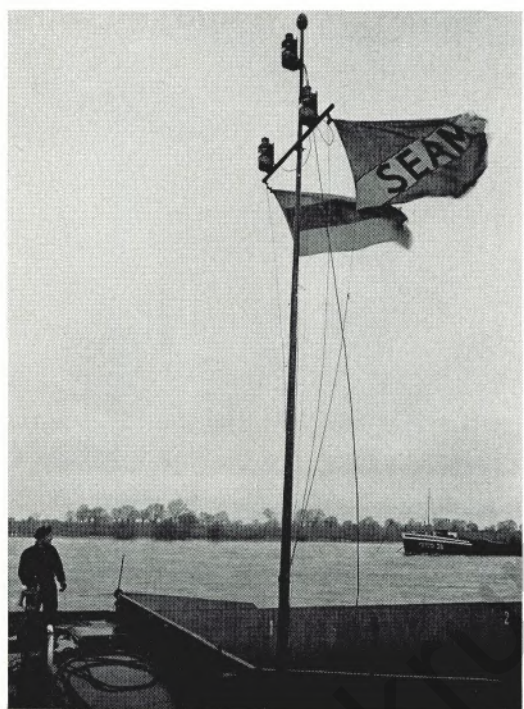
Die Flaggen sind gesetzt — Gleich werden die Anker auf den beiden Leichtern fallen
