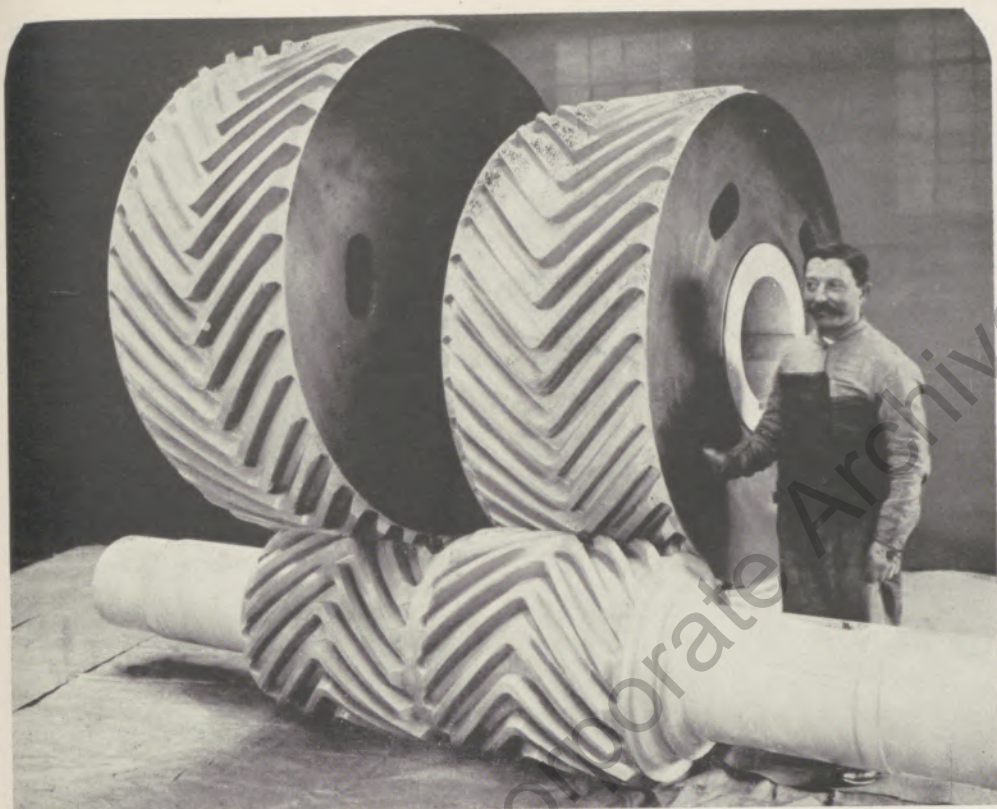
Walzwerksantrieb: Doppel-Kammwalze aus Schmiedestahl mit 2 Kammwalzenringen aus Stahlguß
