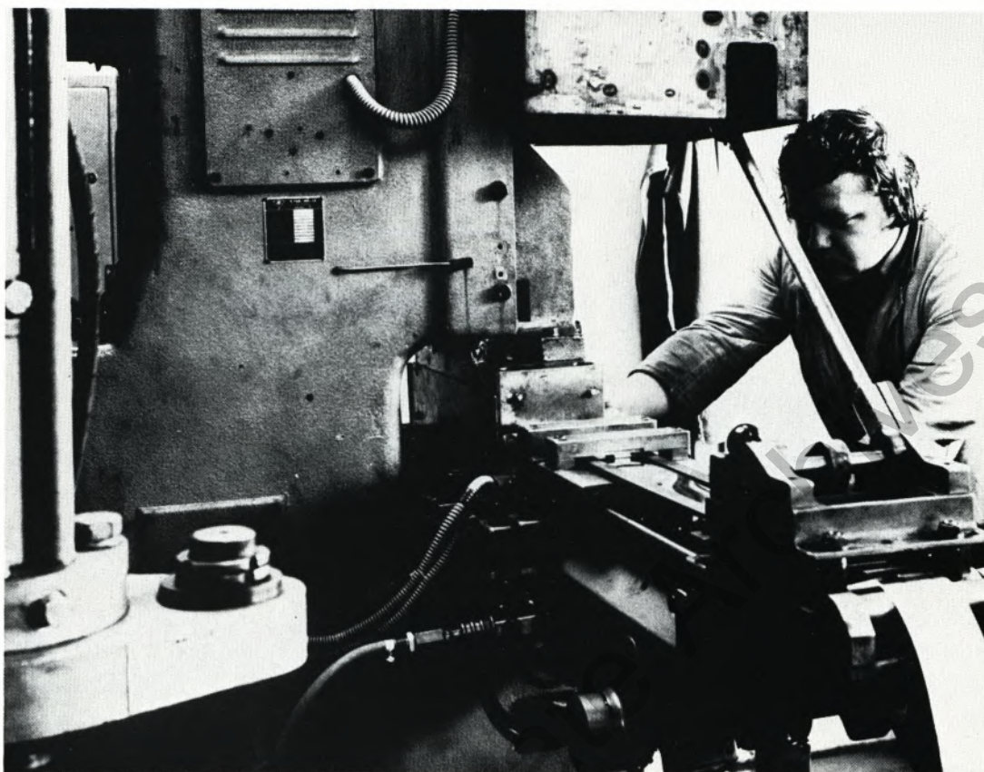
Stoffwärter Peter Kroschinske an der Etiketten-Prägemaschine.
