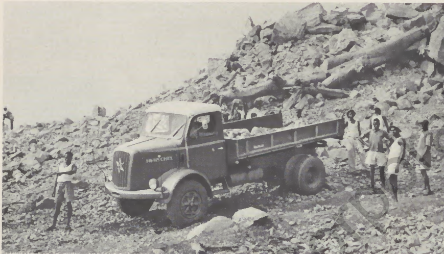
Abb. 1 Beladen eines HS 11 HK mit Baumaterial für den Straßenbau
