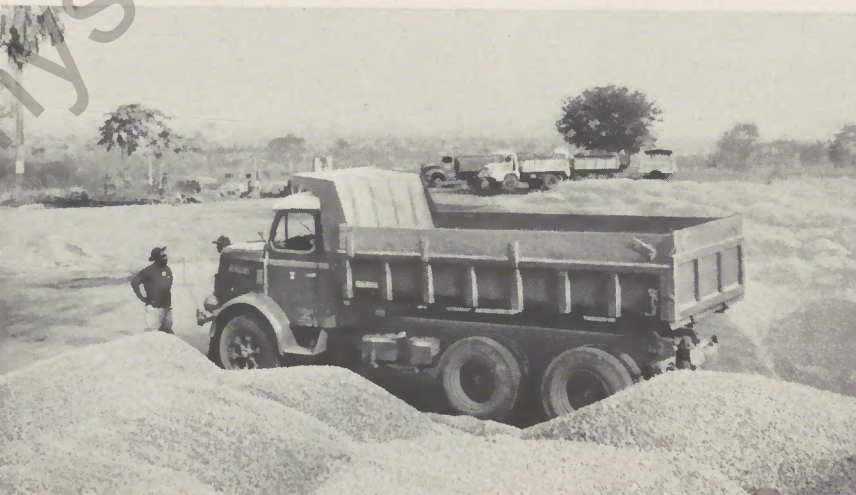
Abb. 3 HS 20 HAK im Baugelände beim Volta-Staudamm
