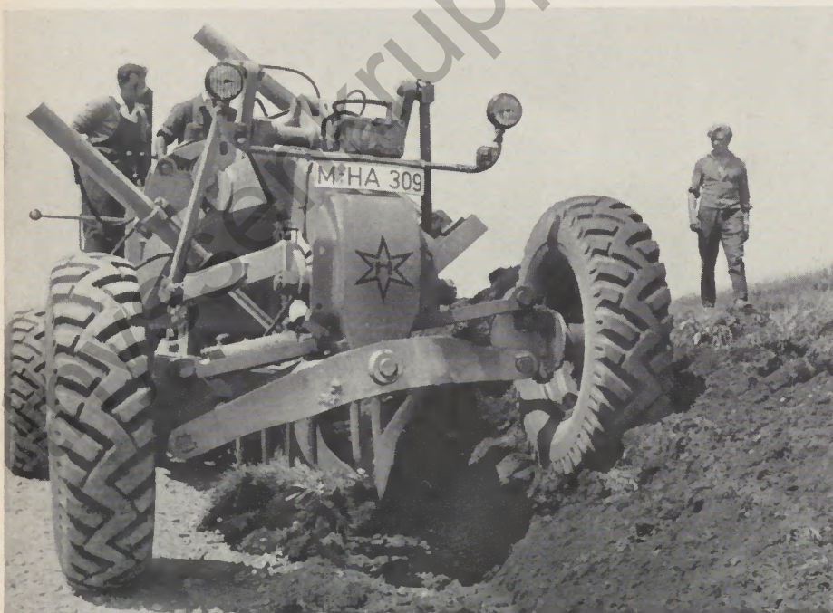
Henschel-Grader beim Grabenziehen und Böschungschneiden
