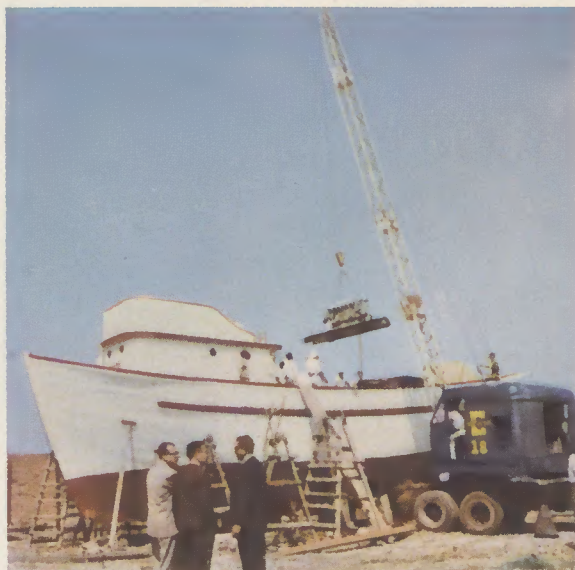
Einbau eines Henschel-Motors 6 R 1215 A in ein Boot von „Perú Fishing“
