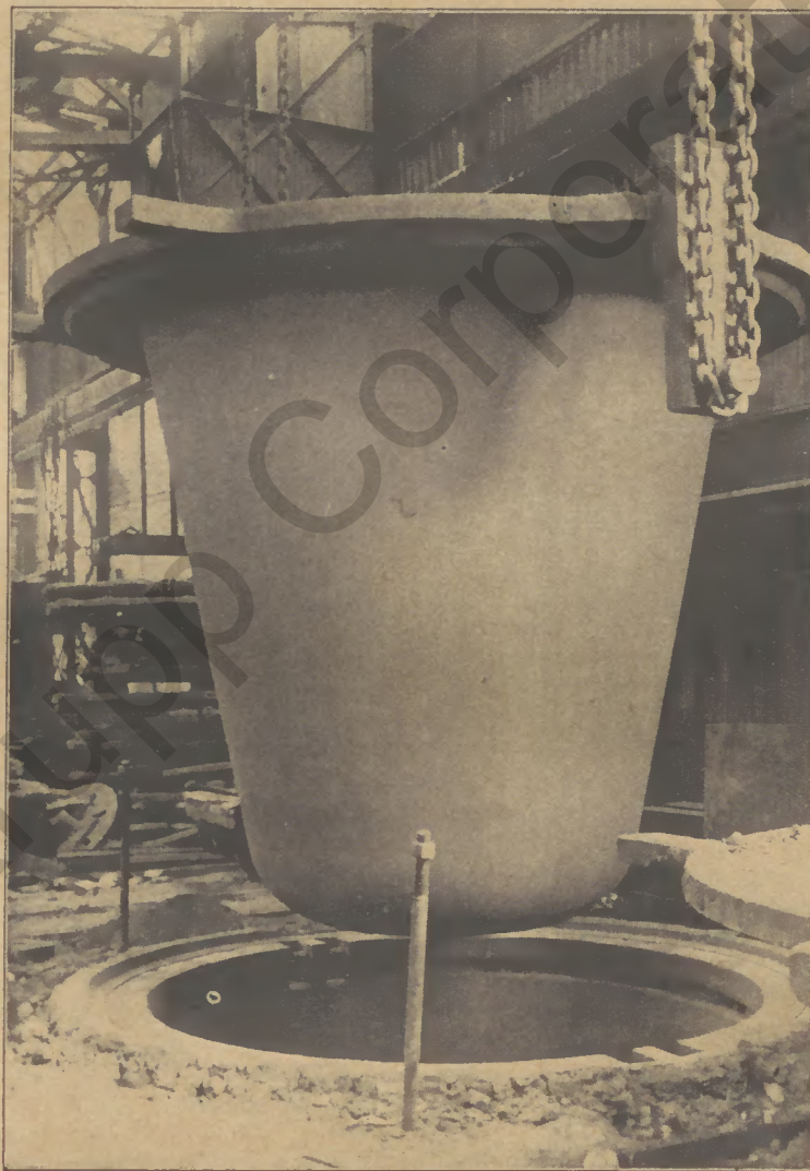
Zusammensetzen der Form für den Guß einer Schlackenspfanne in unserer Eisengießerei.
