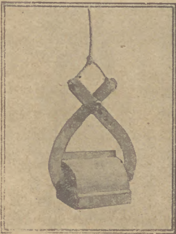
Steinzange zum Heben schwerer Lasten.
