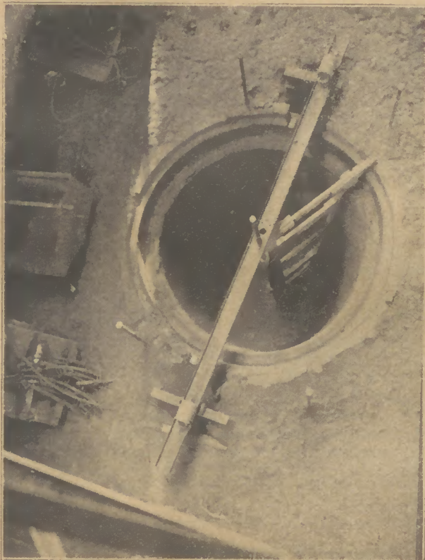
Schablonieren der Unterform.
