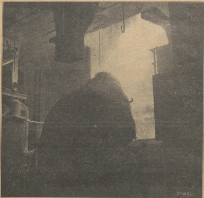
Der Konverter in vollem Gang
