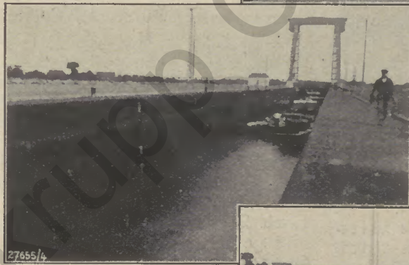
Bild oben: Die Einfahrt eines Schiffes bei hohem Niveau des Wasserpiegels. Bild links zeigt den Schließvorgang. Der Wasserpiegel wird gesenkt. Auf dem unteren Bild ist die Ausfahrt des Schiffes auf dem neuen Wasserpiegel sichtbar.
