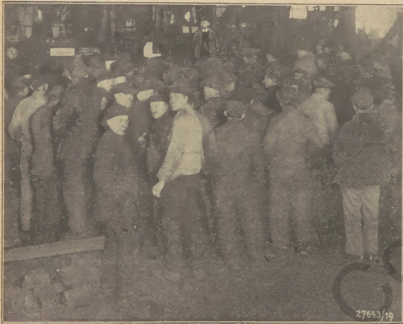
RUVV-Vortrag über die besonderen Gefahren des Brückenbau-Werk- stättenbetriebes, gehalten am 28. Februar 1929 vom Obermeister Böbbis vor der Belegschaft der Brückenbau-Werkstatt der Dortmunder Union
