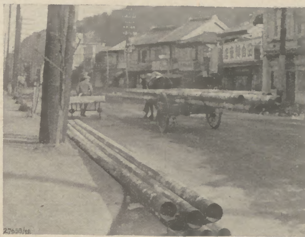
事工設理管新式・社合式鉄鋼東國レウ・社・内市留場 月八二四日入納 社・長 延 中 鋼 鉄 所 留 場 留 場
