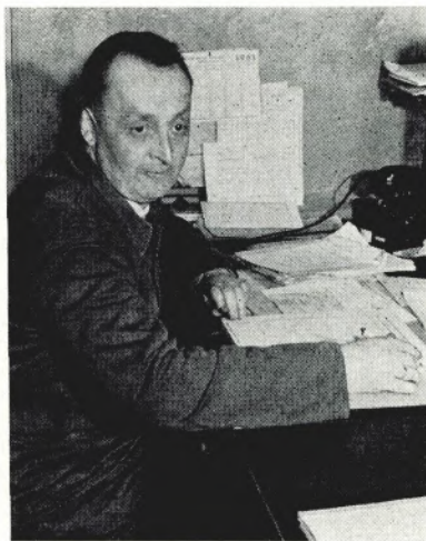
CHRISTIAN BECK, Kolonnenführer Elektrobetrieb I — 12. April
