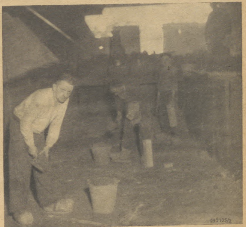
Mauern neuer Gießkanäle in der Grube
