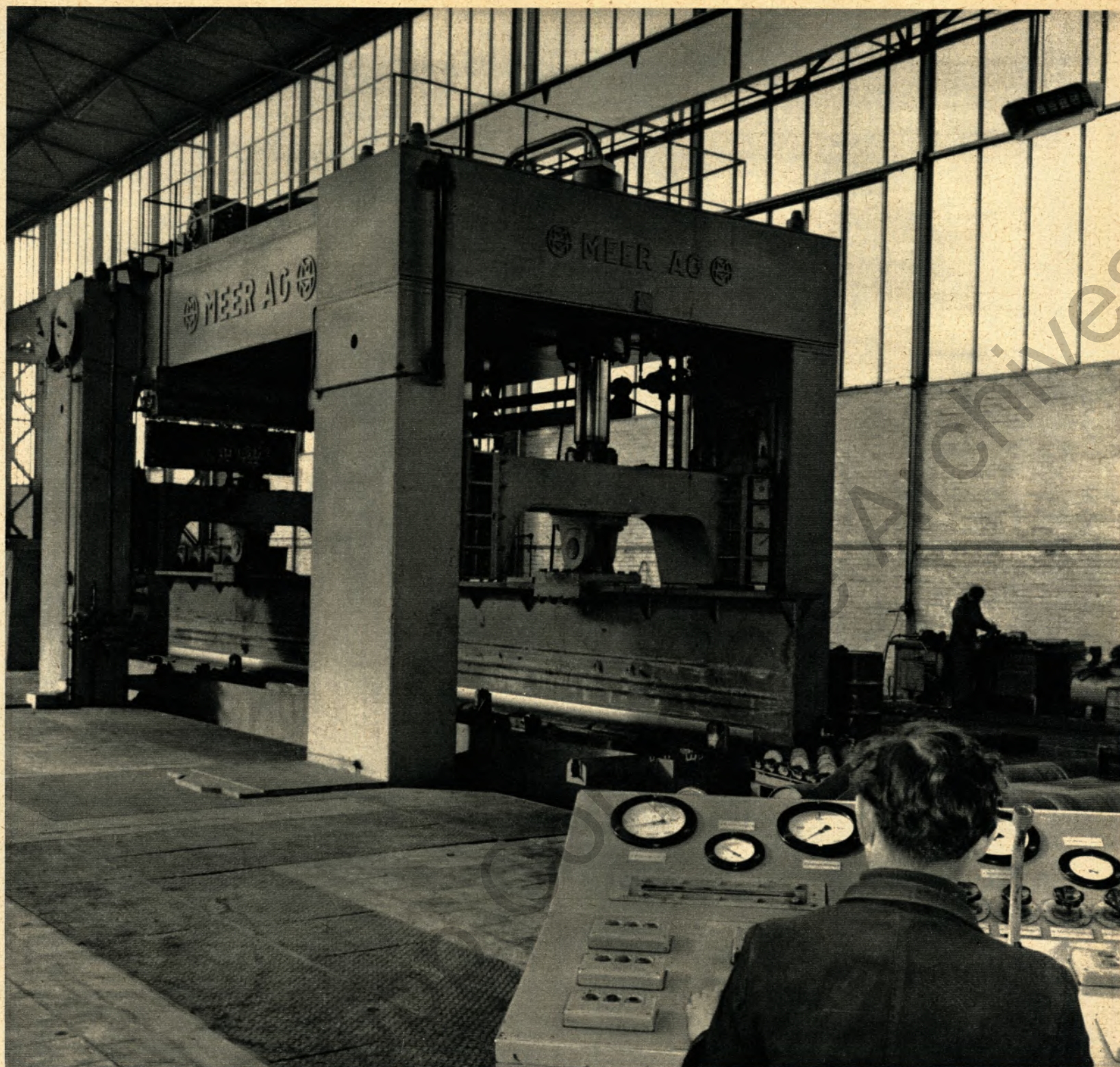
▲ Ein Hub der Presse (rechts) formt das Blech zu U-förmigen Hohlkörpern, aus denen die Großrohre entstehen, die Mannesmann und Hoesch in ihrem gemeinsamen Großrohrwerk in Duisburg/Mündelheim erzeugen (siehe WERK UND WIR, Heft 4/1957)
