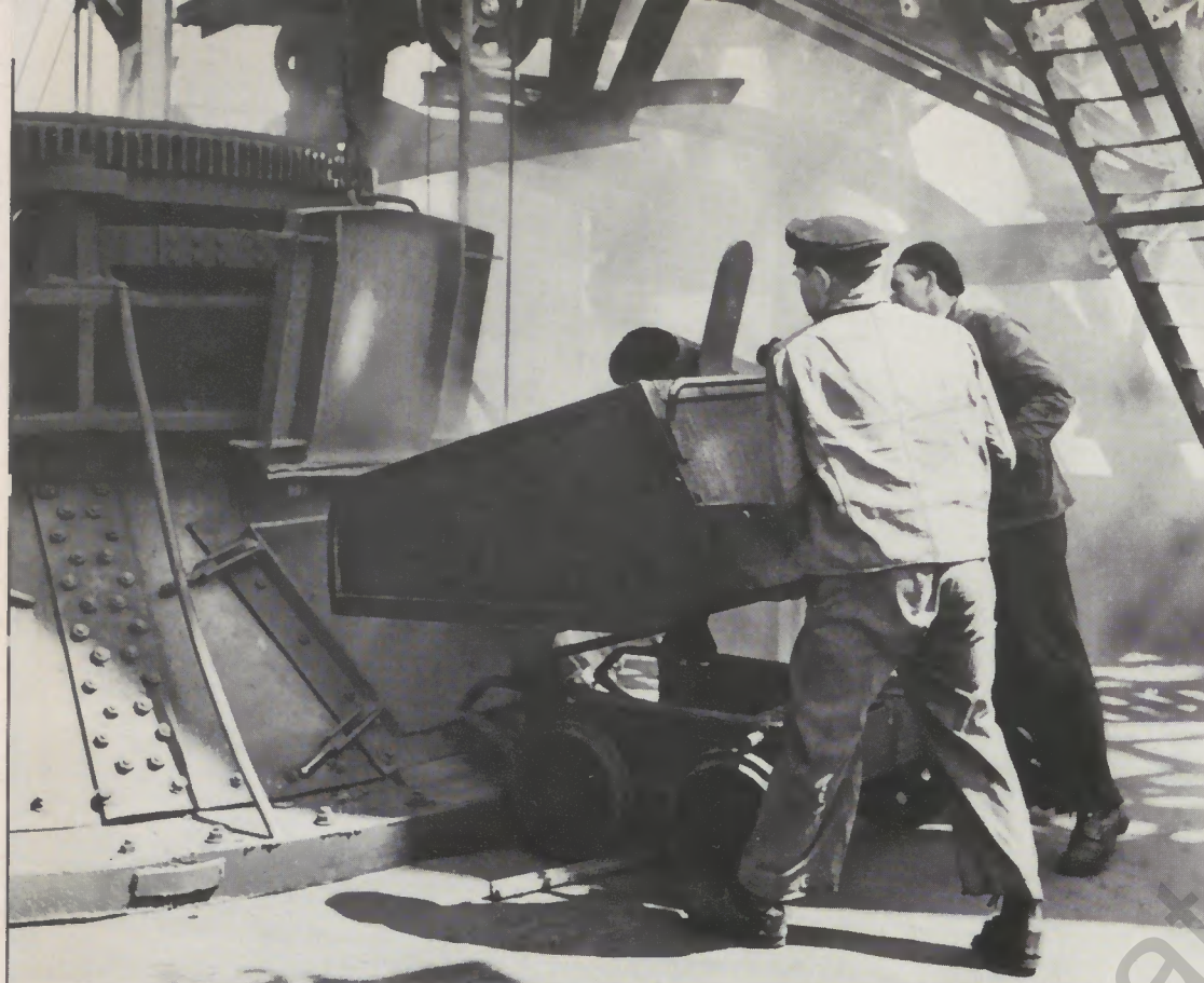
Begichtung des Hochofens (bis 1959): Schrott von Hand zugesetzt
