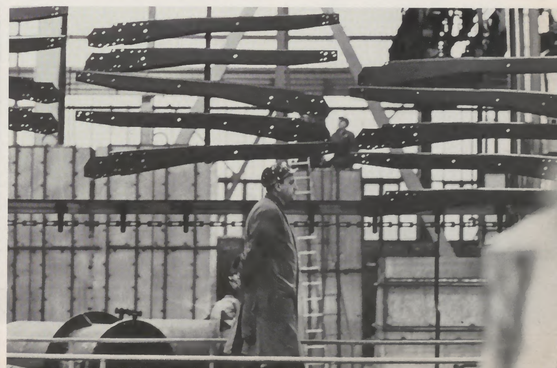
Nach Verlassen der Farbspritzanlage in Brackwede (Technik 1962): Kontinuierlicher Materialfluß
