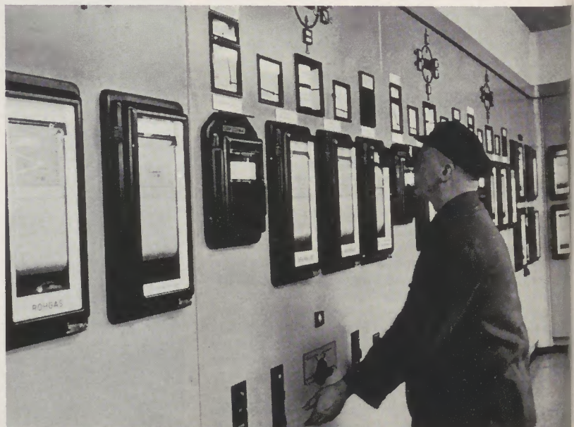
Winderhitzer (Technik 1959): Umschaltung in der Meßwarte
