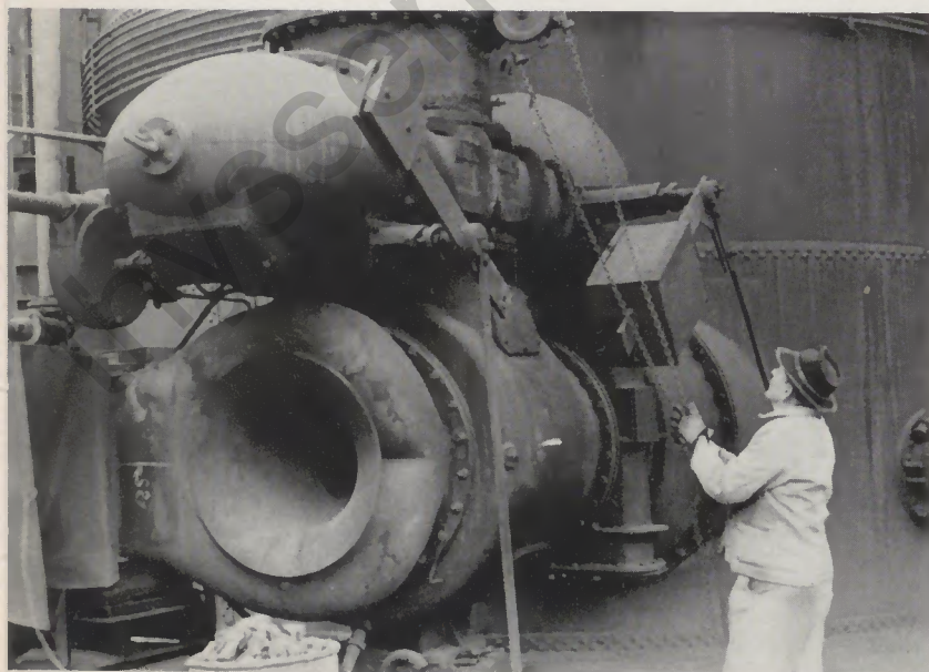
Winderhitzer (alte Technik): Umschaltung mit Kraft und Gefühl
