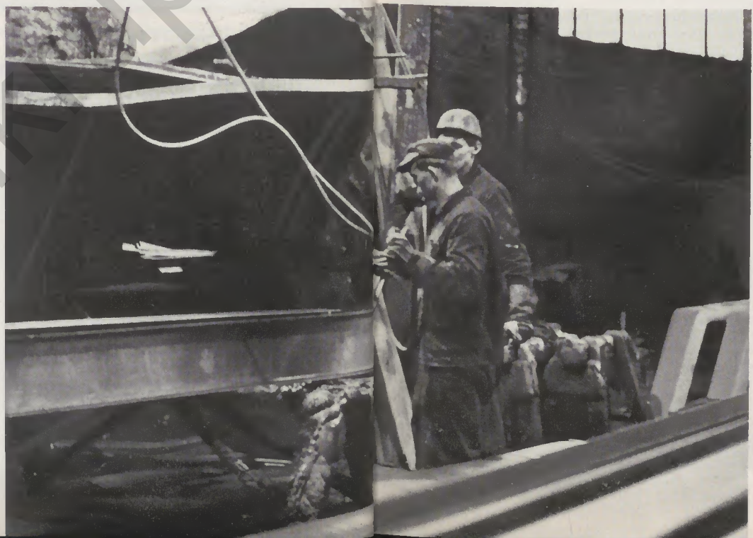
Farbspritzanlage in Brackwede (alte Methode) kontinuierlicher Farbfluß, Transport mit der Hand
