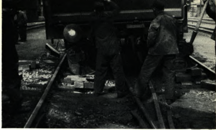
Abb. 3: Aufgleisen mit Hilfe schräg angesetzter „Lechlerheber“.
