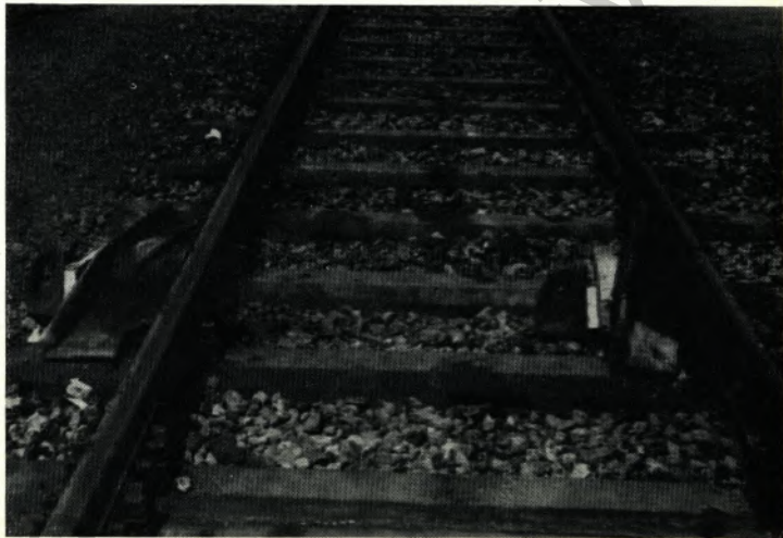
Abb. 4: Neue Aufgleisschuhe mit der Schiene fest verbunden.
