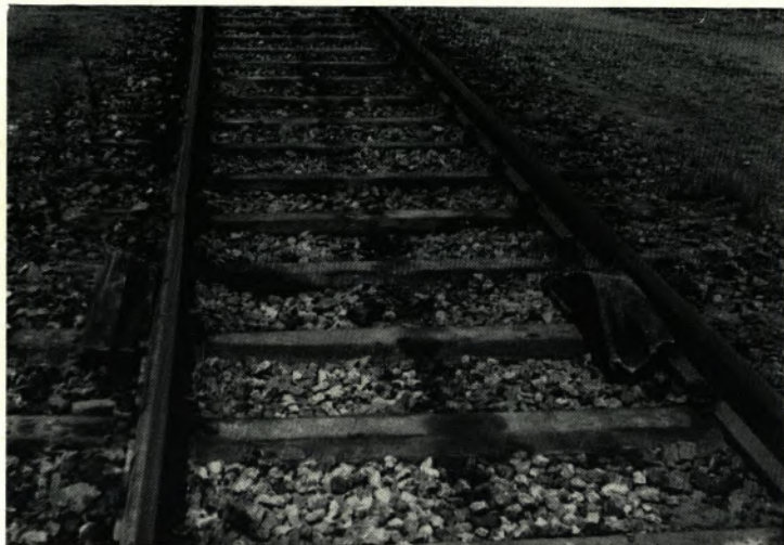
Abb. 1: Über den Schienenbefestigungsschrauben angelegte Aufgleisschuhe alter Bauart. Nachteil dieser Bauart: die Schuhe werden oftmals im letzten Augenblick zur Seite gedrückt.
