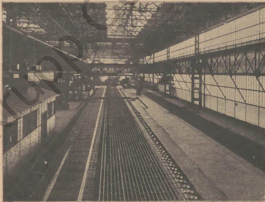
Abb. 10: Mechanisches Kühlbett Ww. 8
