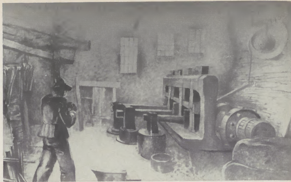
Aus der Mitte des 15. Jahrhunderts stammt die Schmiede, die in Frohnau im Erzgebirge heute noch erhalten ist. Auf dem Bild sind die drei Aufwerfhammer deutlich sichtbar, die durch Wasserkraft angetrieben wurden.
